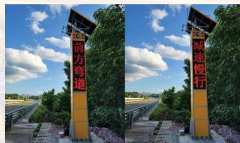
2021 年海南省公安交通综合管控体系升级工程万洋高速智慧交安项目，全部署 42 套综合预警智慧屏，安装在弯道、下坡、汇车、出口等路段前方，并配备无线车辆检测器，无车息屏有车预警，设备应用效果良好。
