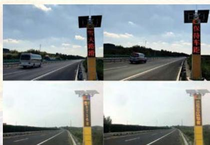
烟台市公安局高速交警支队高速公路安全防护项目，布设了具备恶劣天气检测的综合预警智慧屏，可采集雨雪雾等天气，具备声音播报、红蓝爆闪预警、LED 预警提醒等功能，同时与卡口设备联动，对违法车辆进行时时预警。
