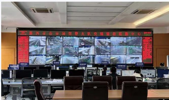
浙江嘉兴市：解决嘉兴市原有麦肯富顿系统专业化过强、使用困难、数据应用不足等问题；同时兼容 GA/T1049.2 和 NTCIP 协议；融合电警、雷达、互联网等数据，实现信号控制的自适应优化
