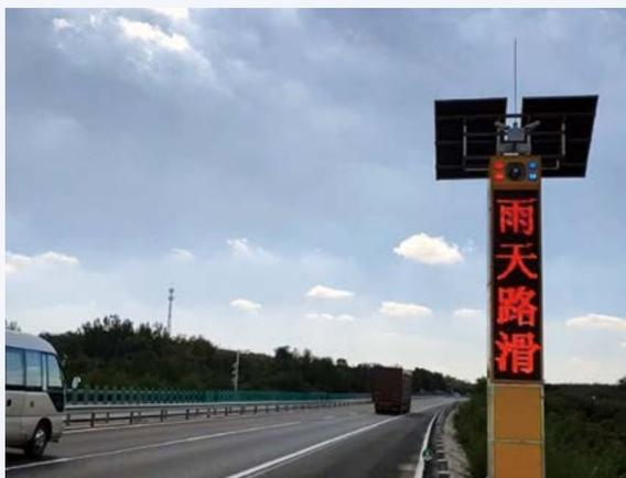
高速公路存在弯道、上下坡、出入口等复杂场景，尤其在雨、雪、雾等突发恶劣天气情况下，极易造成交通事故发生。安全预警智慧屏是一款多功能组合框架式预警屏，采用嵌入式控制、前向散射式能见度仪、气象六要素、LED、定向声音、远程无线传输等技术，具备气象信息采集、LED 文字预警、号角预警、红蓝爆闪灯预警等功能。无车时息屏，可通过无线车辆检测单元采集车辆，并主动点亮预警屏，以可变 LED 文字、红蓝爆闪及高分贝声音等方式，对正行驶在事故多发路段的车辆进行预警提醒，通过安全预警智慧屏，可大大提高道路通行安全性。预警屏可与卡口设备关联，自动播报违法车辆号牌。支持远程控制，
